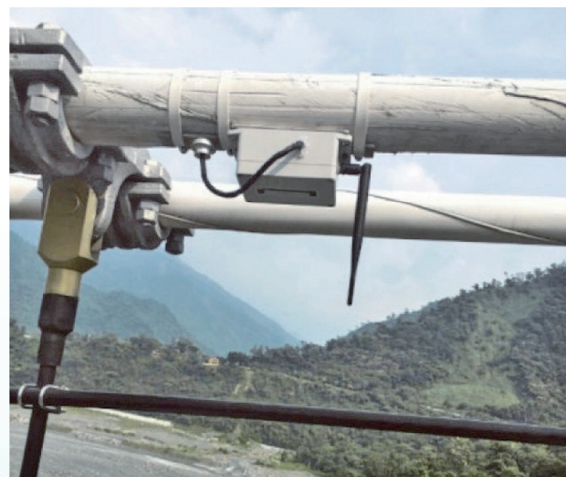
圖 19 加速規之現場安裝與監測照片
