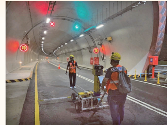
(1) 主線隧道掃描作業
