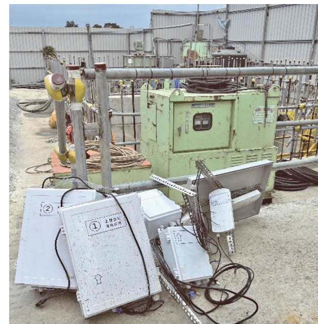
圖 12 本案例設備卸除後照片
