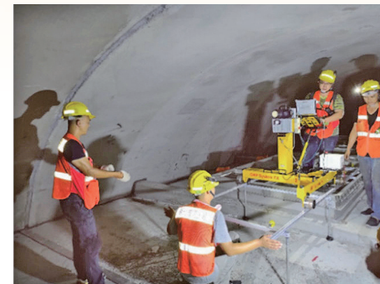
(3) 通風管道掃描作業
