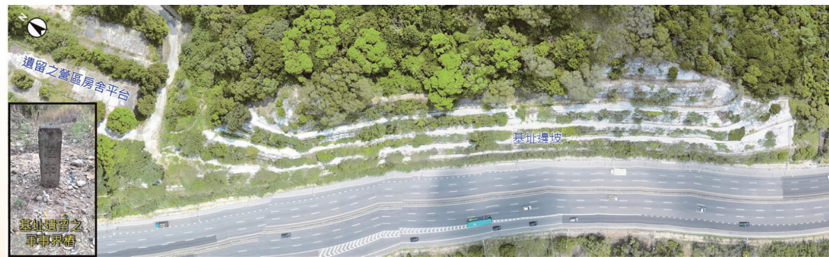
圖 5 案例基址現況空拍影像
