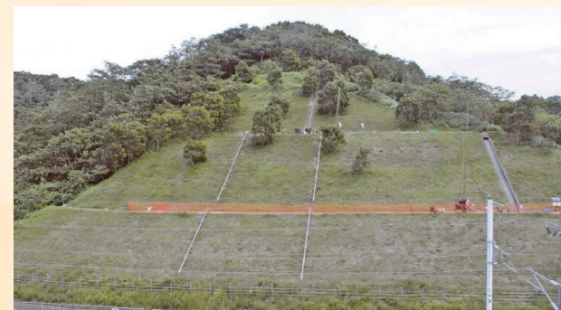
圖 2 邊坡現況照片
